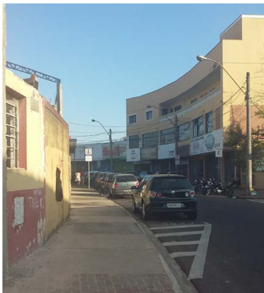
Trecho da Av. Alfredo Maffei, onde o Córrego do Gregório está tamponado. Fonte: LIMA, M. C. P. B. 2016.
